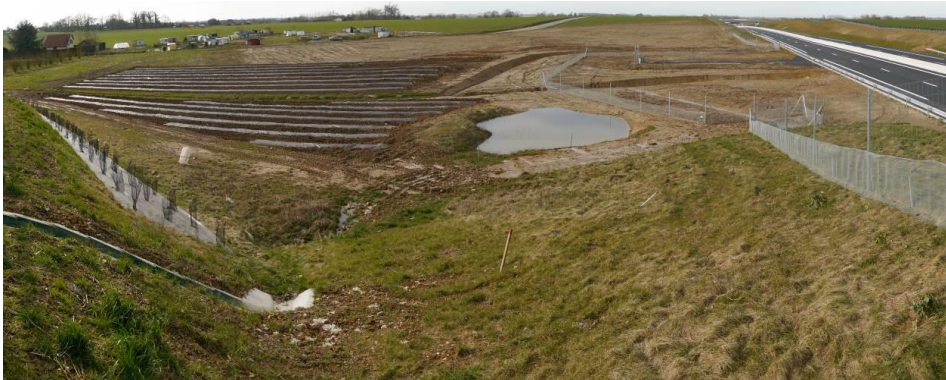
Vue sur la zone aménagée, secteur Courvaudon, à l'ouest de l'A150. ©O.G.E.-V. Vignon
