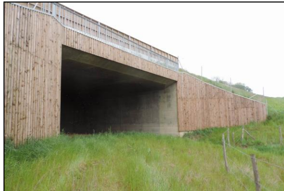
Vue sur le passage inférieur à faune
