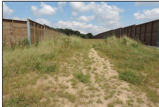
Vue sur le passage supérieur à faune
