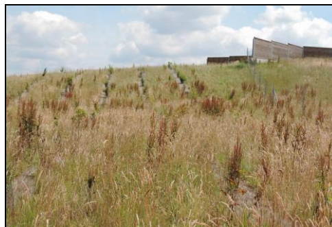
Vue sur le passage supérieur à faune
