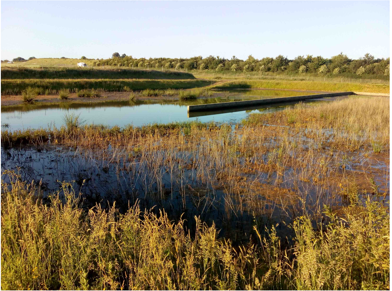
Photo n°10 : site de la Charrue : Bassin
