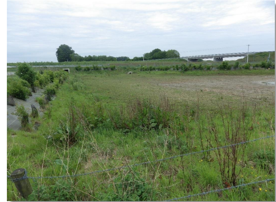
Photo 15 - Zone humide créée en sortie du bassin BM25.5 – PR25.40 (Photo RBC Projet – Mai 2018)
