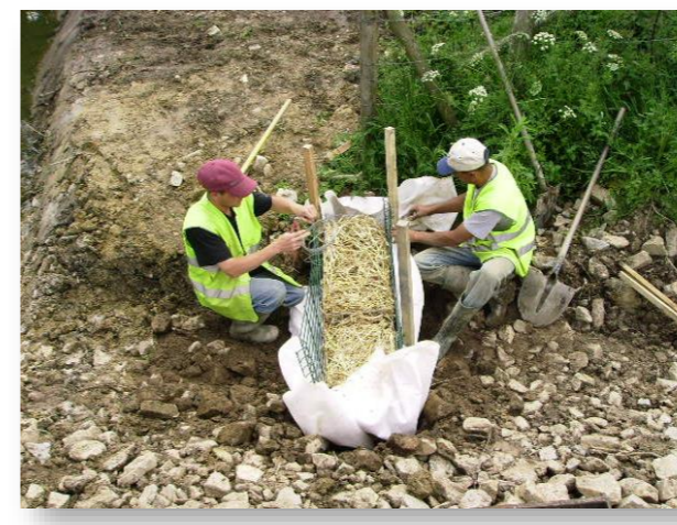
Photo 19 - Installation d'un filtre à paille
