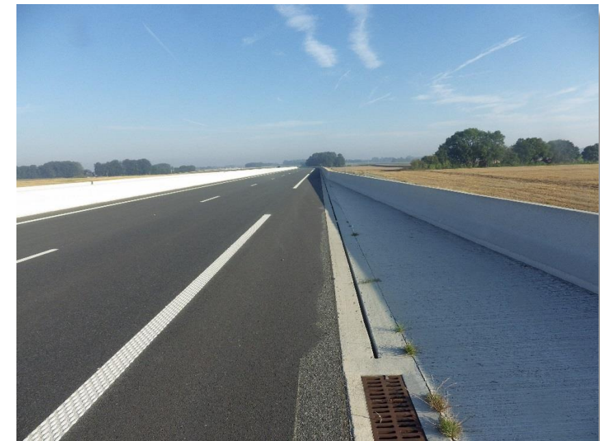
Photo 4 - - GBA anti déversement sur la zone de traversée du périmètre de protection éloigné du capotage de Limézy – PR24.52
