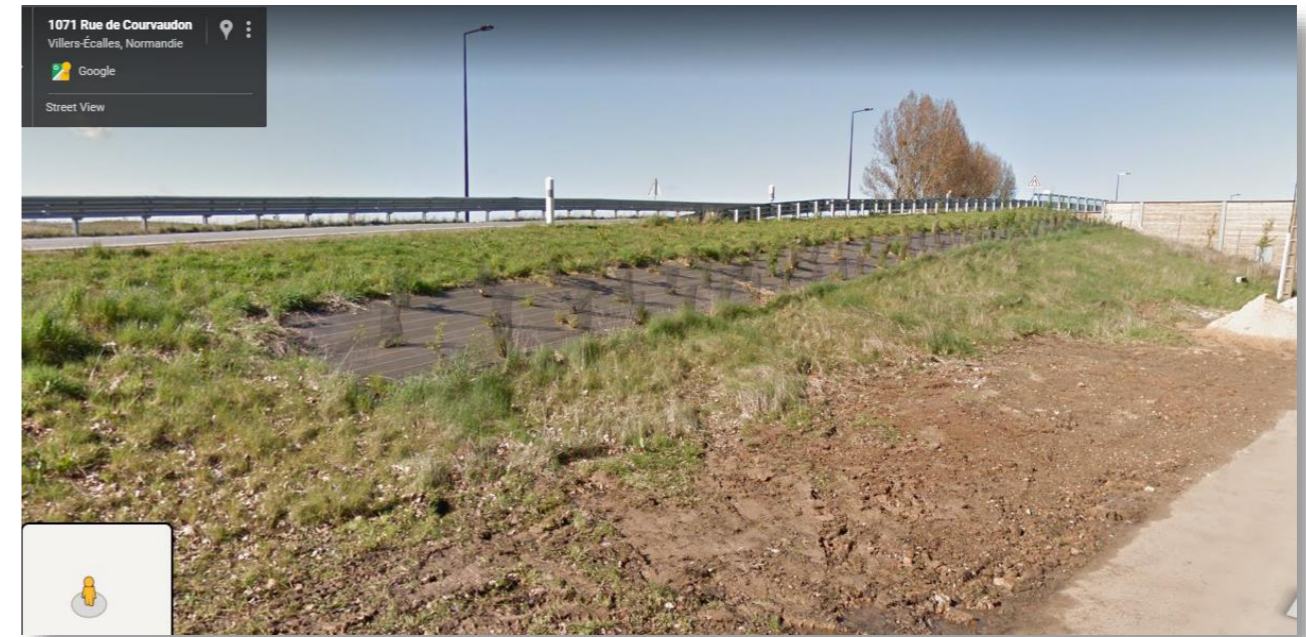
Photo 40 – Talus planté du VC2 rétabli à Villers Ecalles (Street View 2016)
