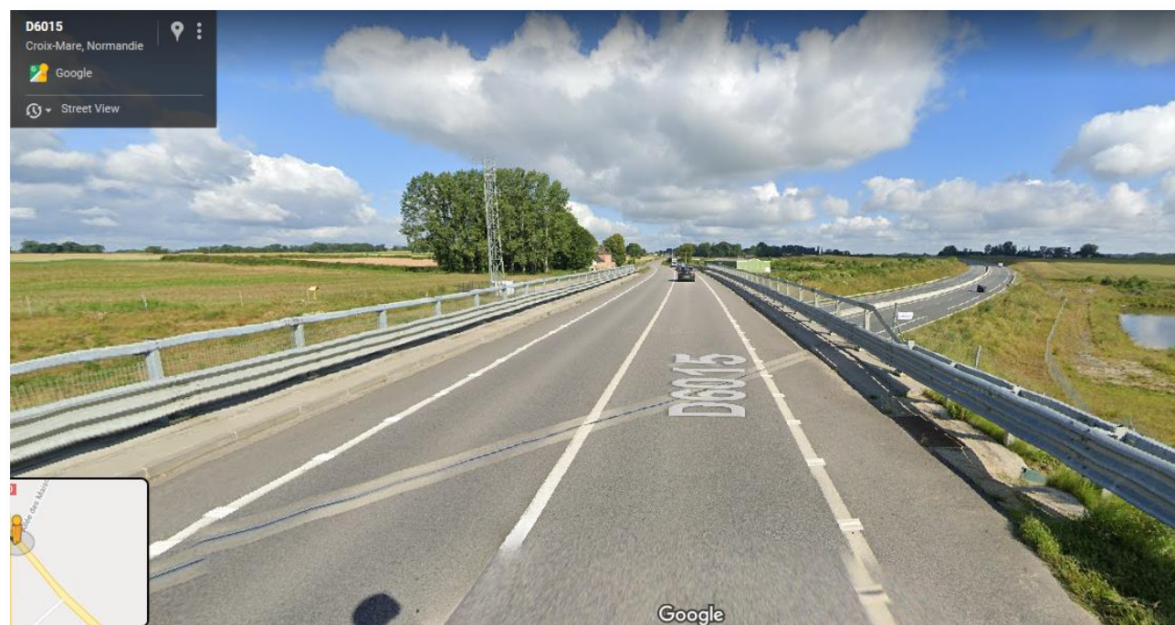
Photo 37 - Ouvrage de franchissement de la RD6015 conforme aux normes Convois exceptionnels – Extrait Google Maps StreetView
