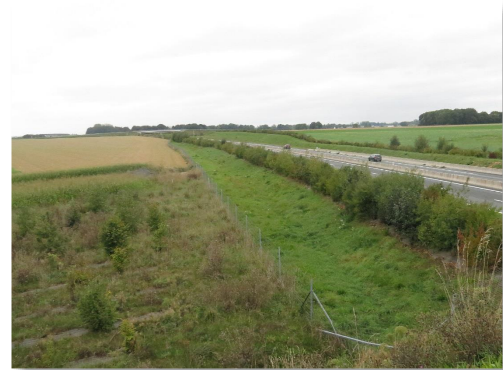
Photo 38 – Module 8 sur merlon – secteur la Dialonde –PR25.56 (Photo RBC Projet 2020)
