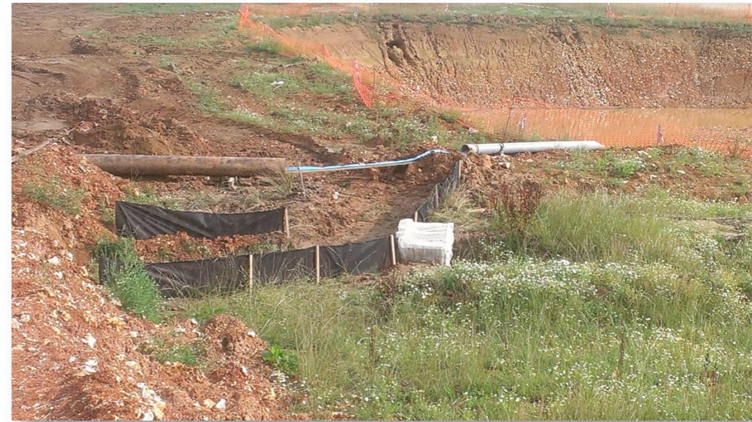
Photo 1 - Bassin provisoire sur le secteur du Bois de Sap à Mesnil Panneville (Août 2013 – Photo RBC Projet)
