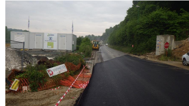
Photo 22 – Travaux de reprofilage de la RD143 extraite rapport LIMANDAT Mai 2014
