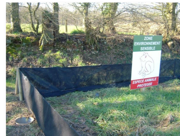
Photo 9 - Filet à batracien empêchant l'accès à l'emprise travaux et seuil de collecte des batraciens pour transfert vers mare voisine et signalisation de la zone environnementale sensible. (Photo OGE)
