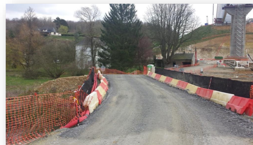
Photo 32 - Pont provisoire permettant le franchissement de l'Austreberthe (Photo INGEROP – février 2014)
