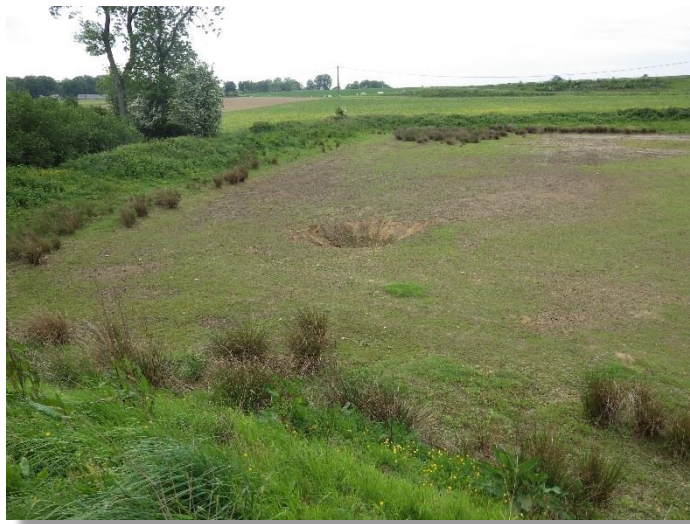
Photo 8 - Effondrement dans la zone humide aval du PI1076 – PR17.87
