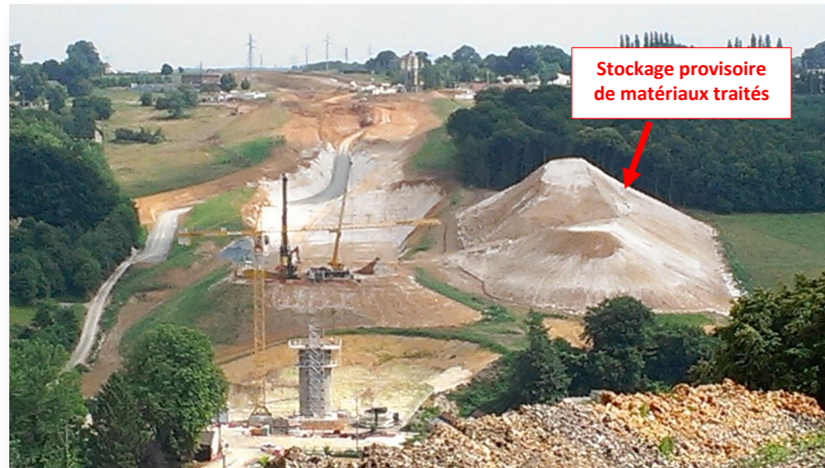
Photo 13 - Stocks provisoires à l'intérieur des emprises des futurs bassins de traitement
