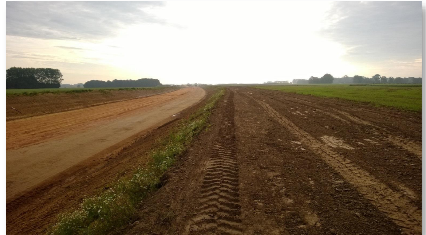
Photo 16 - Remise en état des terrains empruntés pour la circulation pendant le chantier (partie droite de la photo) et restitution à l’agriculture (la teinte brune de la terre correspond à la terre végétale remise en place dans le cadre de la remise en culture)
