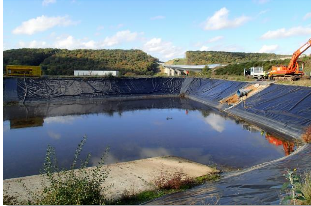
Photo 9 - Travaux de reprise au droit de l'ouvrage d'entrée du BM13.6 – PR13.62
