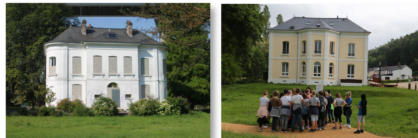
Photo 30 - Bâtiments acquis par le SMBVAS (à droite photo 2015 avant travaux – à Gauche photo juin 2018)
