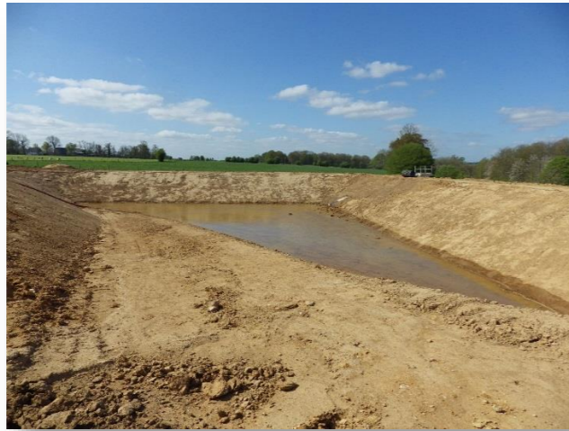
Photo 17 - Exemple de bassin provisoire réalisé au début des travaux de terrassements
