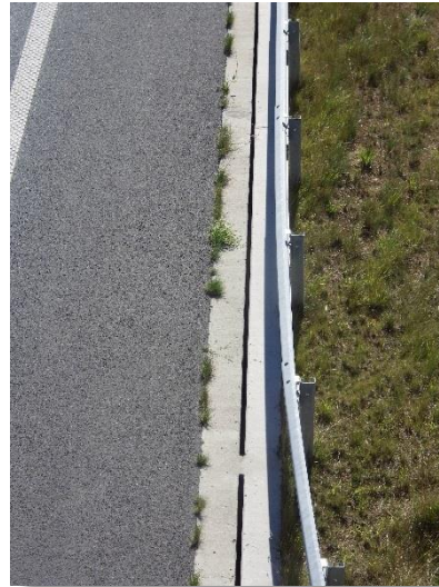
Photo 10 -- Réseau latéral de collecte des eaux pluviales - Caniveau béton-- PR26.12
