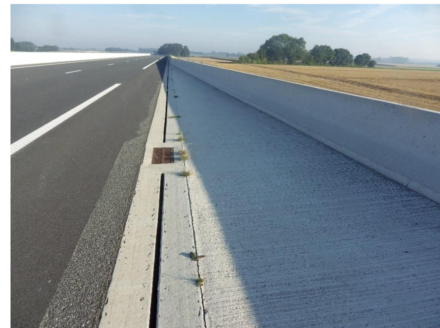
Photo 1 - Caniveau Béton dans la traversée du Captage de Limézy – PR24.52
