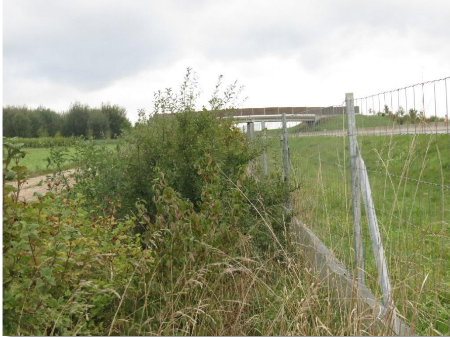
Photo 89 – clôture autoroutière avec doublage par treillis petite faune au PR26.34 – photo RBC Projet septembre 2020
