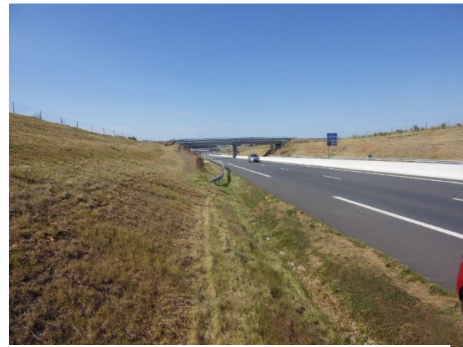
Photo 11 - Réseau latéral de collecte des eaux pluviales – Cunette dissymétrique– PR15.42
