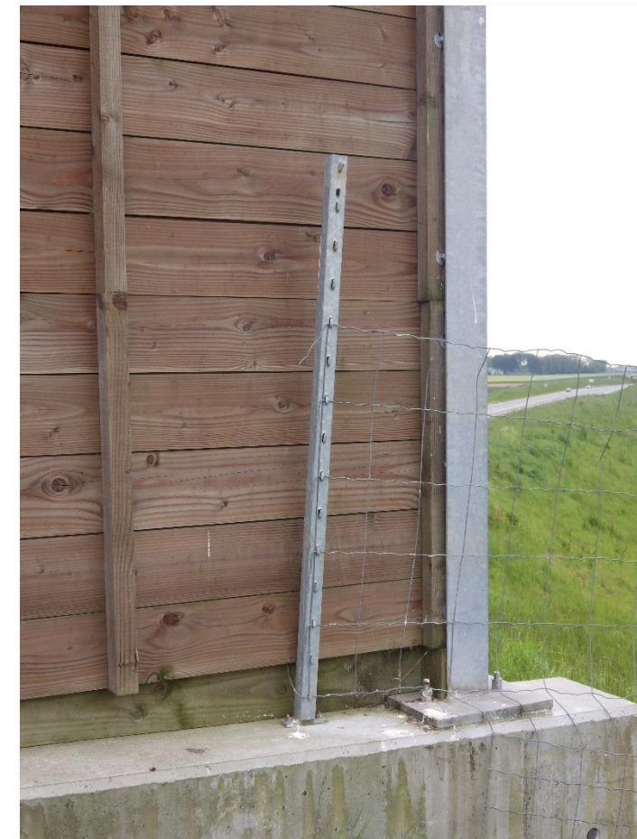
Photo 43 – raccordement clôture sur écran occultant du PGF du Bel Événement – PR26.60 – photo RBC Projet mai 2018
