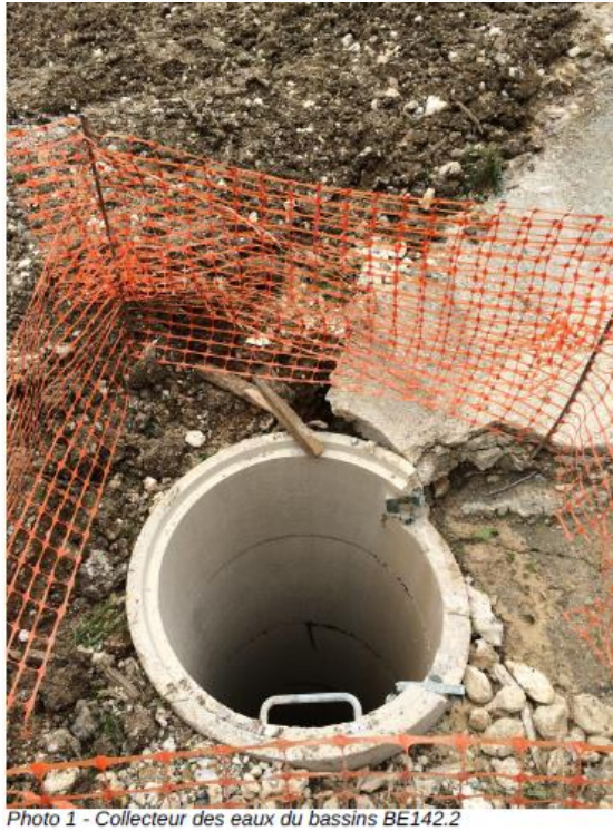
Photo 1 - Collecteur des eaux du bassin BE142.2
