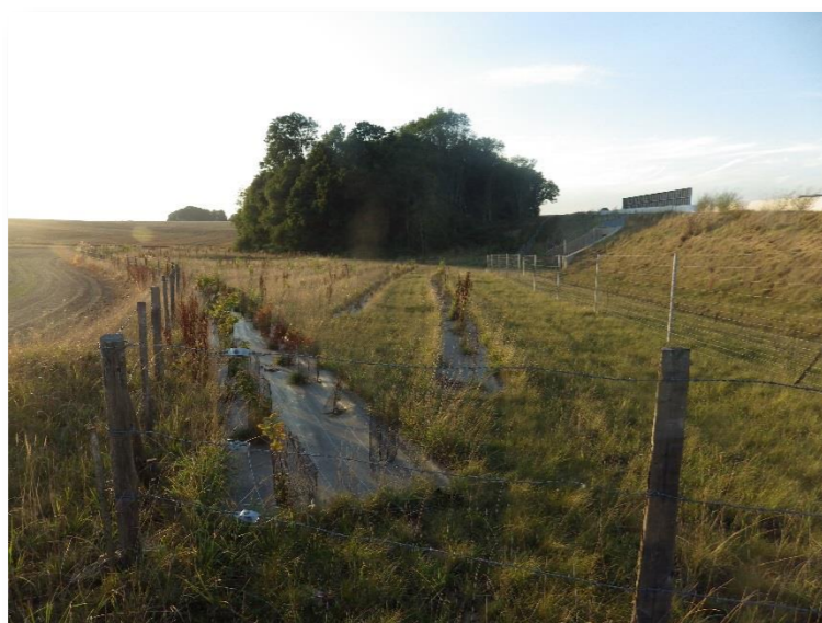
Photo 8 – Franchissement en remblai du talweg du bois de Sap et plantations d'accompagnement – PR21.74 – Mesnil Panneville (Photo RBC Projet)
