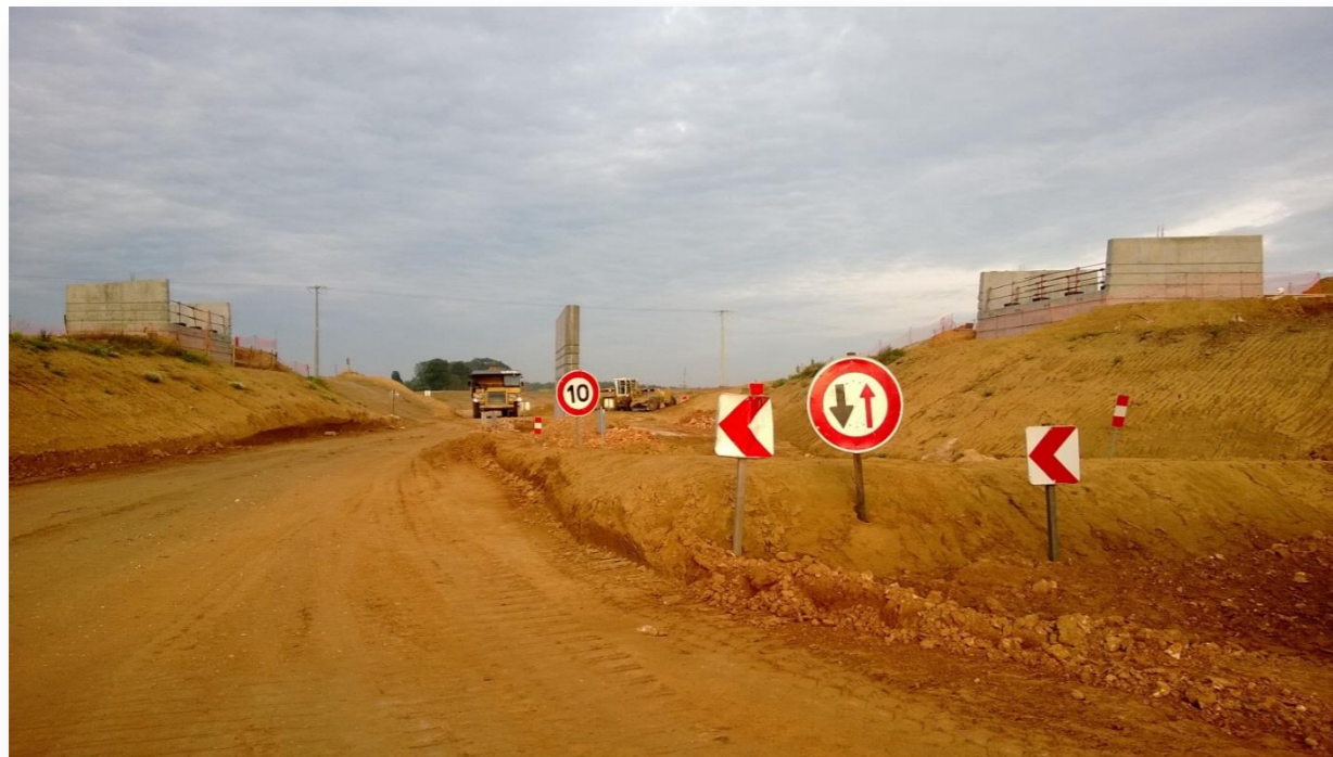
Photo 15 - Signalisation adaptée pour la circulation des engins et des transports d’approvisionnement du chantier
