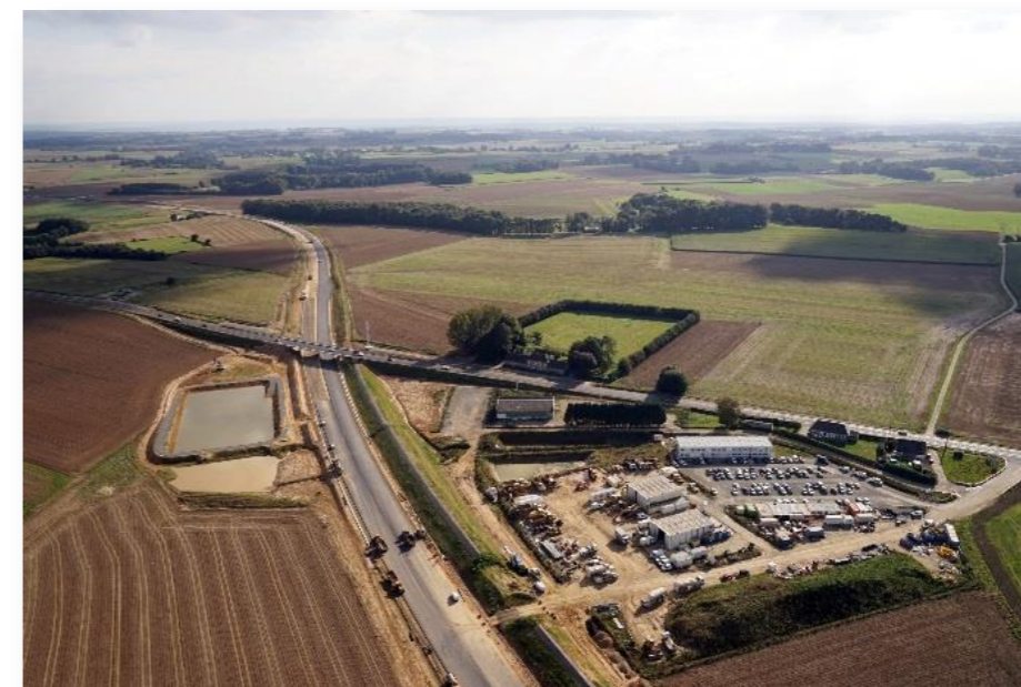
Photo 8 - Installation de chantier de Mesnil Panneville
