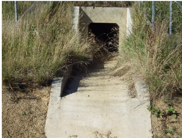
Photo 23 – Ouvrage hydraulique de type cadre béton – PR24.04 (Photo RBC Projet Août 2016)
