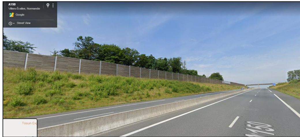
Photo 5 –écran acoustique au droit du lieu-dit Courvaudon (propriété Hillard) - commune de Villers Ecalles – PR14.80 (source photo – Google Earth Pro)
