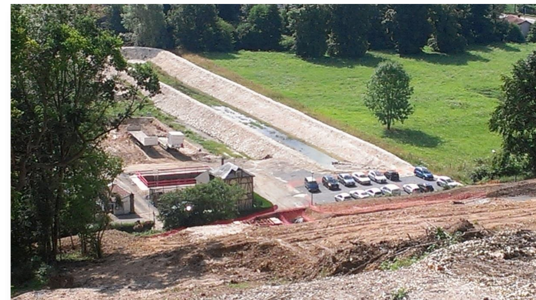
Photo 2 - Bassin assurant la gestion des eaux de la piste de chantier en fond de vallée de l'Austreberthe (Août 2013 – Photo RBC Projet)
