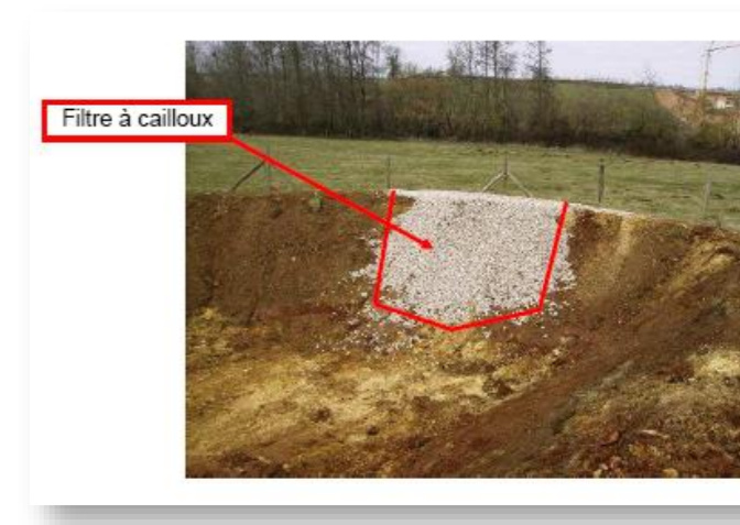
Photo 20 - Exemple de filtre à cailloux
