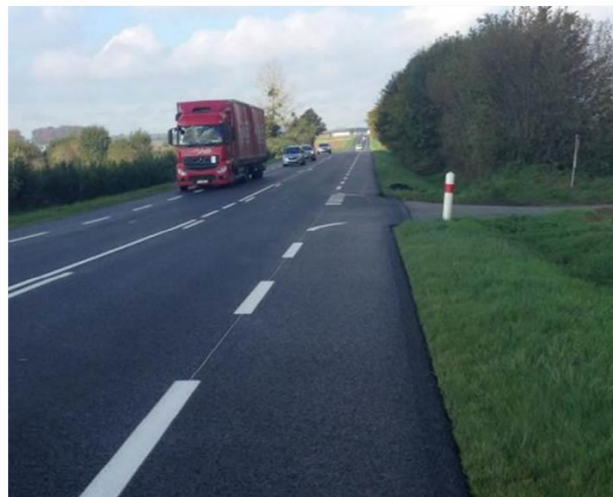
Photo 23 - Aménagement de bandes multifonctionnelles sur RD601 (Photo CD76 – 2017)
