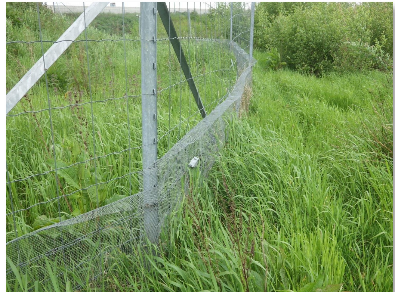
Photo 46 - Clôture petite faune et batracien – PR26.76 (Photo RBC PROJET Août 2016)
