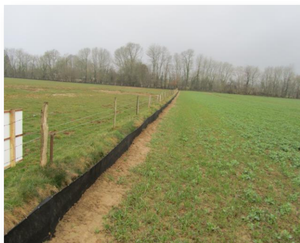
Photo 4 – Clôture anti batracien et seau de collecte – secteur de Courvaudon – Villers Ecalles (2013- Source INGEROP)
