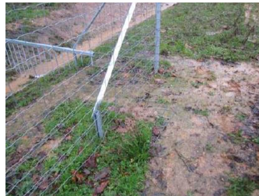
Photo 39 - Jambe de force (Photo RBC Projet Novembre 2015)
