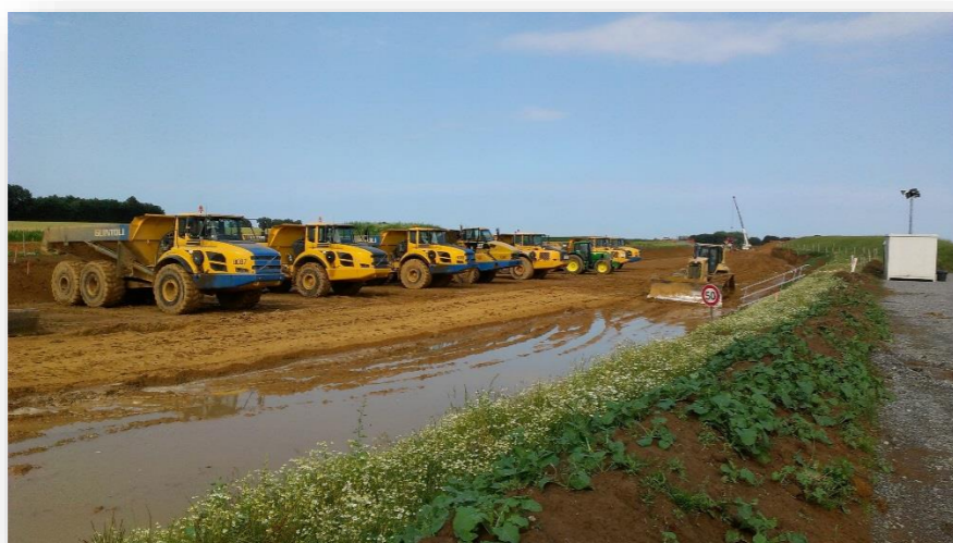
Photo 30 - Zone de stationnement des engins de chantier à l'écart des habitations – Motteville (Photo RBC Projet – Juillet 2013)
