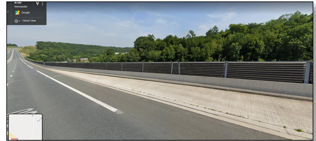
Photo 3 – Photo écran acoustique culée sud viaduc de l'Austreberthe - commune de Barentin – PR13.50 (source photo – Google Earth Pro)
