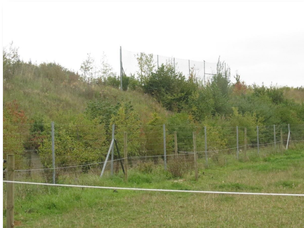
Photo 47 – Clôture surélevée au droit du hop over de Boscriscard – PR19.18 – photo RBC Projet septembre 2020
