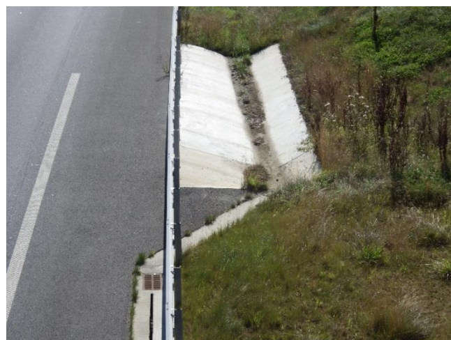
Photo 3 - Traitement du raccordement cunette / caniveau – PR15.42
