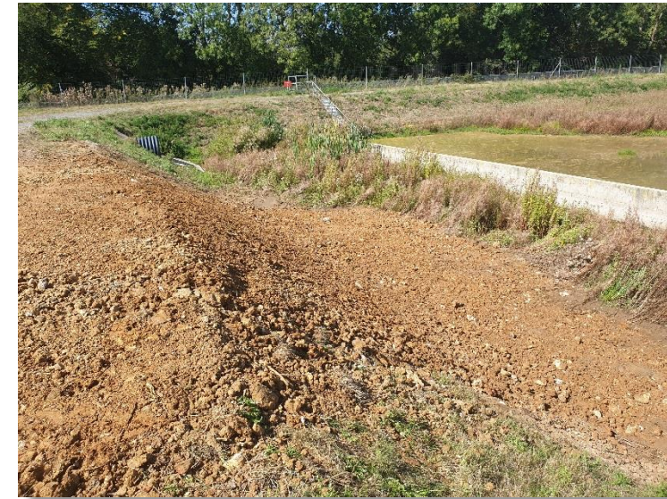
Photo 7 - Effondrement dans le bassin BM109.2 – PR17.87 – Après travaux
