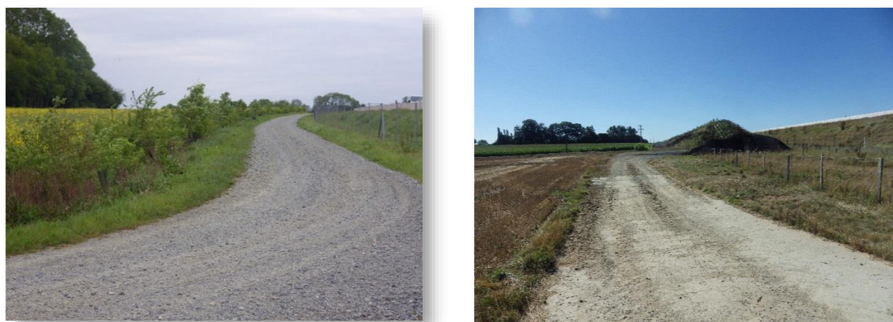
Photo 21 - Photos chemin d'exploitation agricole depuis RD20 – ferme de la Dialonde Motteville (RBC Projet Août 2016)
