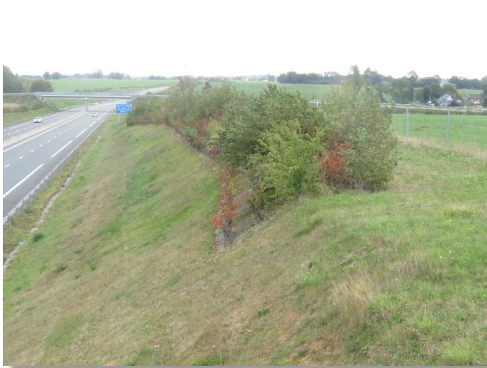
Photo 112 – plantations d'intégration en crête de déblai – PR18.56 – photo RBC Projet septembre 2020
