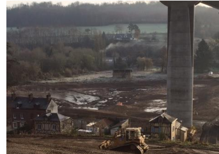
Photo 19 - Zone Humide de l'Austreberthe terrassée – Barentin (Mars 2015) – PR14.18 – Photo INGEROP
