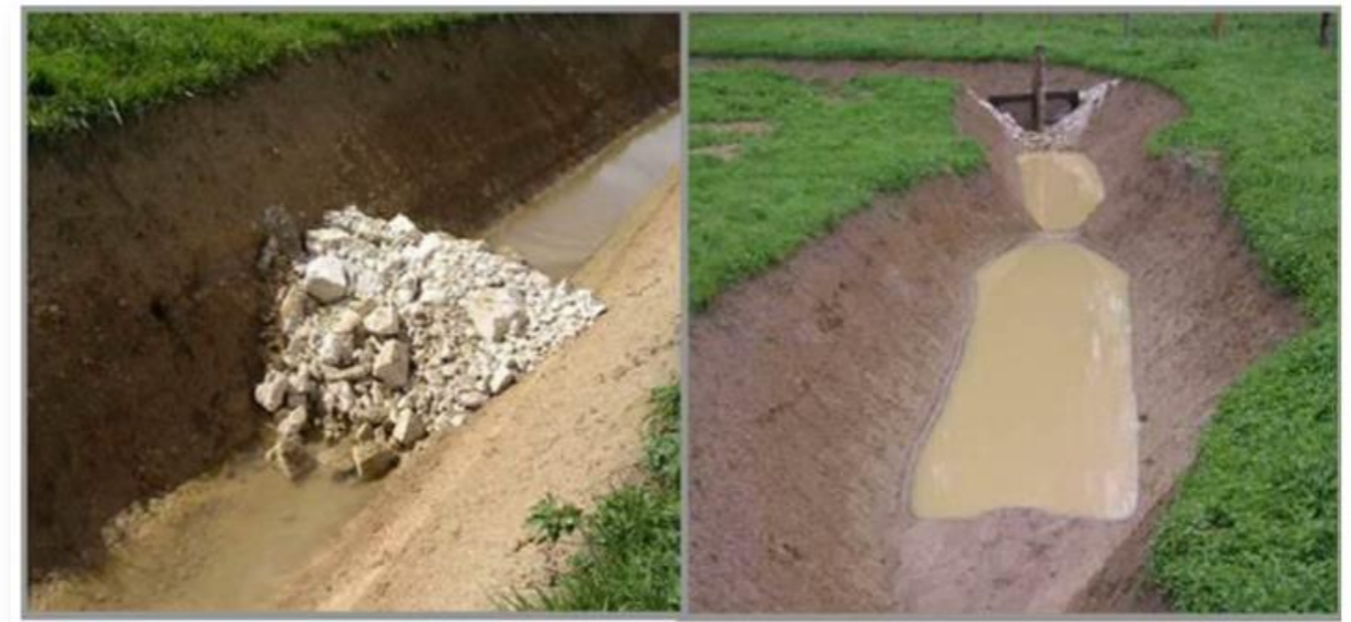
Photo 18 - À gauche, fossé amont aménagé avec des seuils en cailloux pour casser l'énergie et limiter les phénomènes érosifs par réduction des vitesses instantanées. À droite : blocage en caillou du filtre à fines
