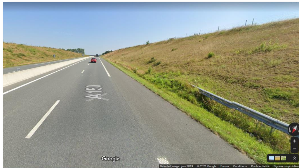
Photo 12 - Talus végétalisé et fauché – PR15.42 (Villers Ecalles) – Extrait Google Maps Street View Juin 2019
