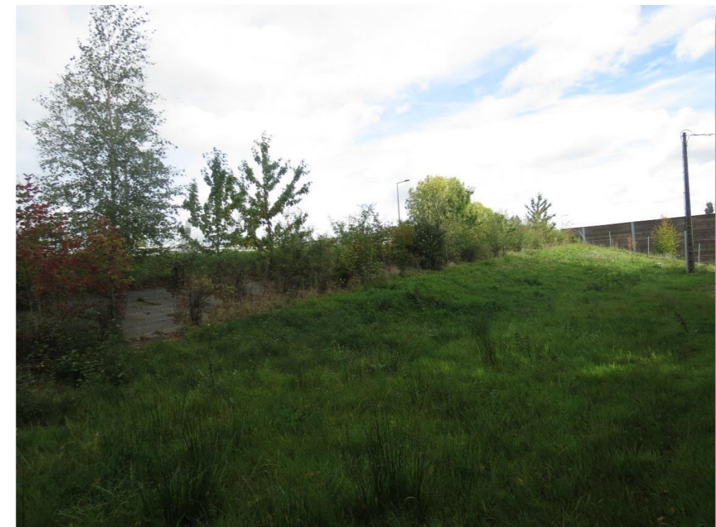
Photo 41 – talus du VC2 planté en Module 9 – PR14.94 (photo RBC Projet septembre 2020)
