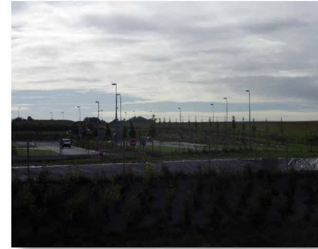
Photo 58 - Éclairage halte simple – PR15.88 (Photo RBC Projet septembre 2016)
