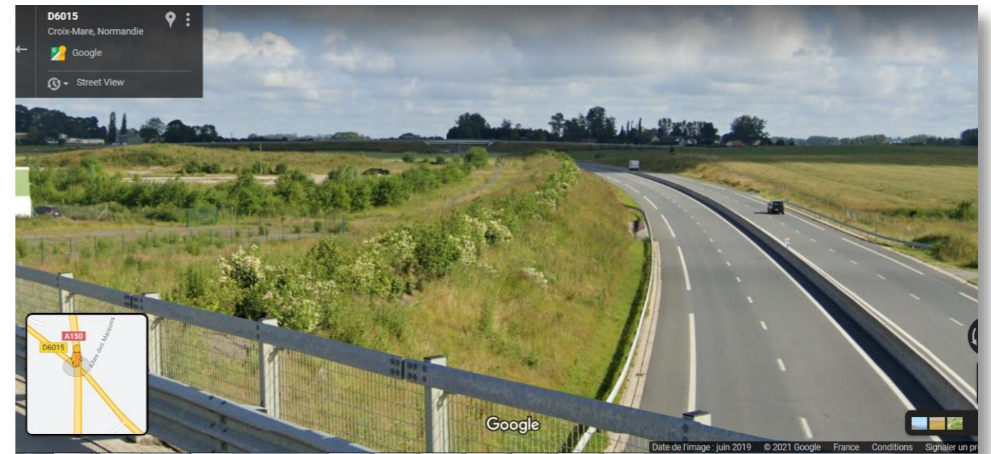
Photo 39 – Module 8 sur merlon Bosc Hérisson – Mesnil Panneville (Street View juin 2019)
