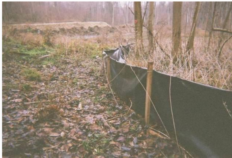
Photo 23 - Exemple de dispositif empêchant l'accès des batraciens aux emprises de travaux en phase chantier
