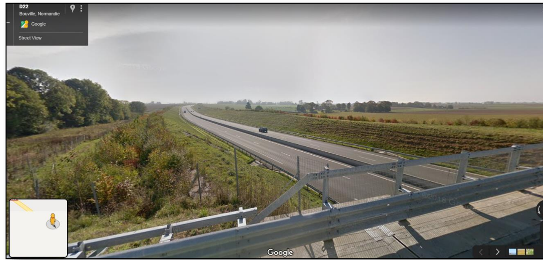
Photo 1 – Merlons acoustiques de part et d'autre de l'A150 au lieu-dit la Charrue – commune de Bouville – PR18.14 (source photo – Google Earth Pro)
