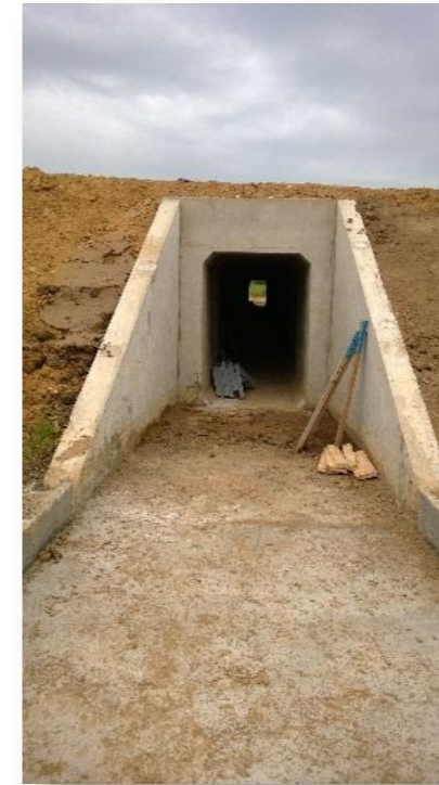
Photo 24 - Cadre béton en cours de pose (OHA5642) – PR23.05
