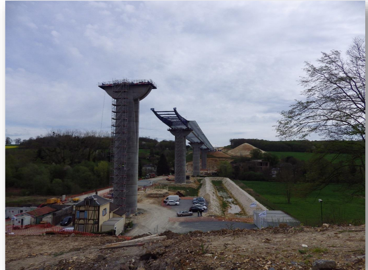
Photo 34 - Piste de chantier en fond de vallée de l'Austreberthe
