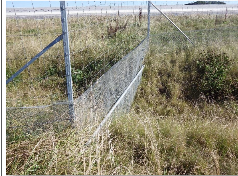
Photo 42 – grille sur fossé doublée d’un treillis petite faune – PR26.36 – photo RBC Projet août 2016
