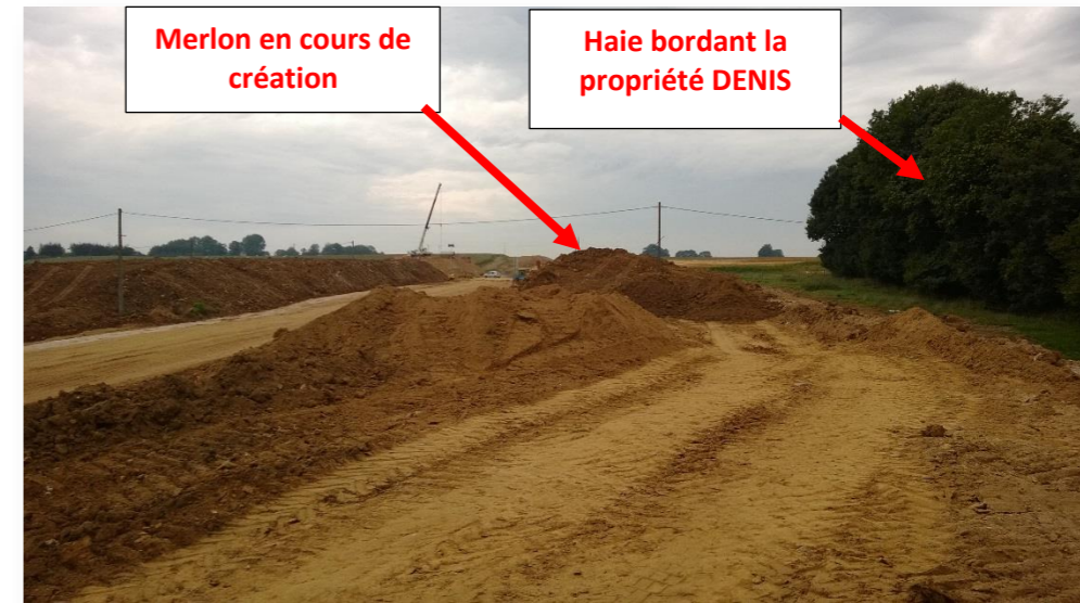
Photo 27 - Merlon en cours de création au début des opérations de terrassement – La Charrue (Bouville) – PR18.06
