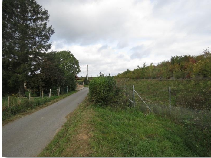
Photo 110 – A droite haie arbustive sur merlon phonique au droit du hameau de la Charrue à Bouville – photo RBC Projet septembre 2020
