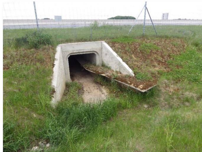
Photo 38 - PPF1900 – côté Ouest – PR26.78 Flamanville (Photo RBC Projet Mai 2018)
