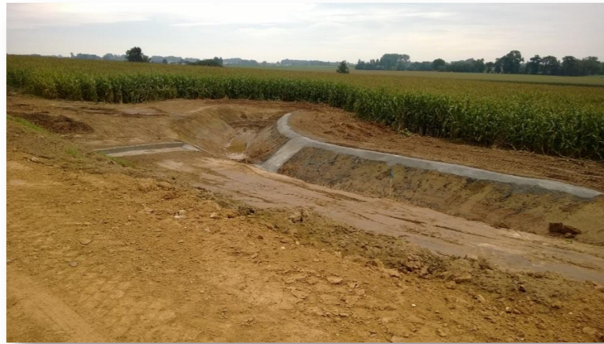
Photo 26 - Exemple de lame de diffusion avec seuil béton – Aval OHA8922 au PR19.76 (Bouville) (Photo ALBEA – octobre 2013)
