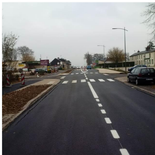
Photo 26 - Traversée de Croix Mare après travaux de requalification de la RD6015 en 2017 (photo CD76)
