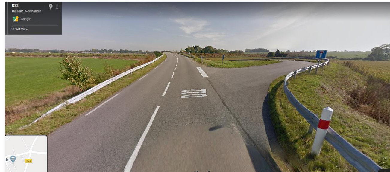
Photo 36 - Exemple de rétablissement direct de la RD22 franchissant l'A150 et sur la droite rétablissement indirect de la rue de la Charrue – commune de Bouville (76) – Extrait Goolge Maps StreetView
