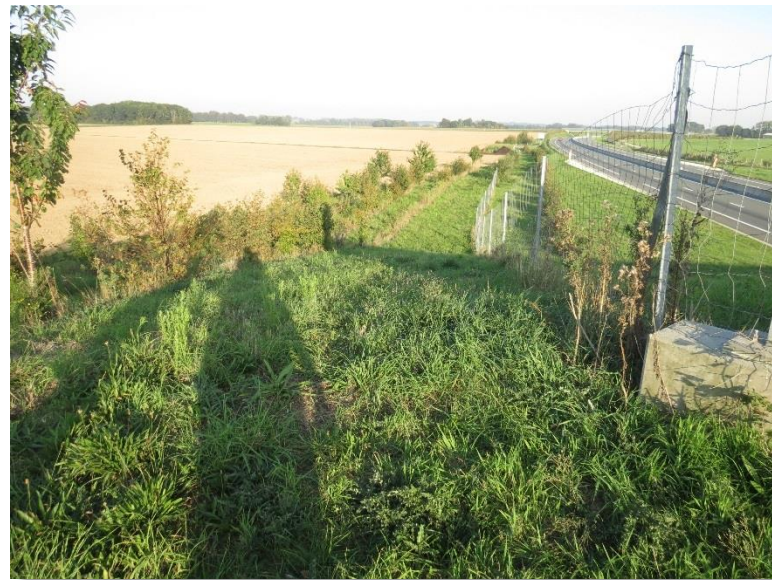
Photo 90 – clôture autoroutière se raccordant sur les écrans occultants du PGF du Bel Évén – PTR26.60 – photo RBC Projet septembre 2020
